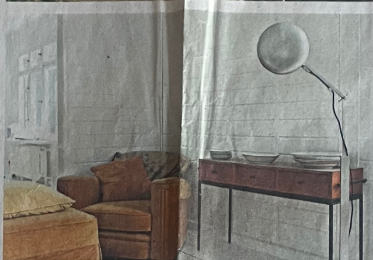
Gut getarnt: Das Dahlemer Kupferhaus wurde im Zweiten Weltkrieg weiß gestrichen. Im Inneren ersetzt Wohnstahlblech in unterschiedlichen Mustern die übliche Tapete. Anstelle von Nägeln nimmt man Magnete.
